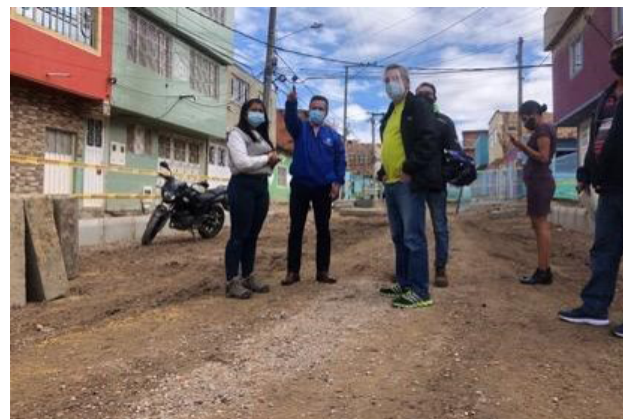
Inspección a terreno recorrido vías contrato 304-18 - Ciudad Bolívar
